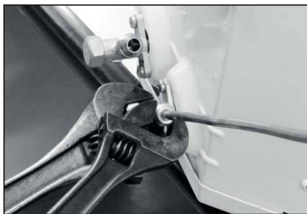
FIG. 41 - FIXAÇÃO DA PORCA
